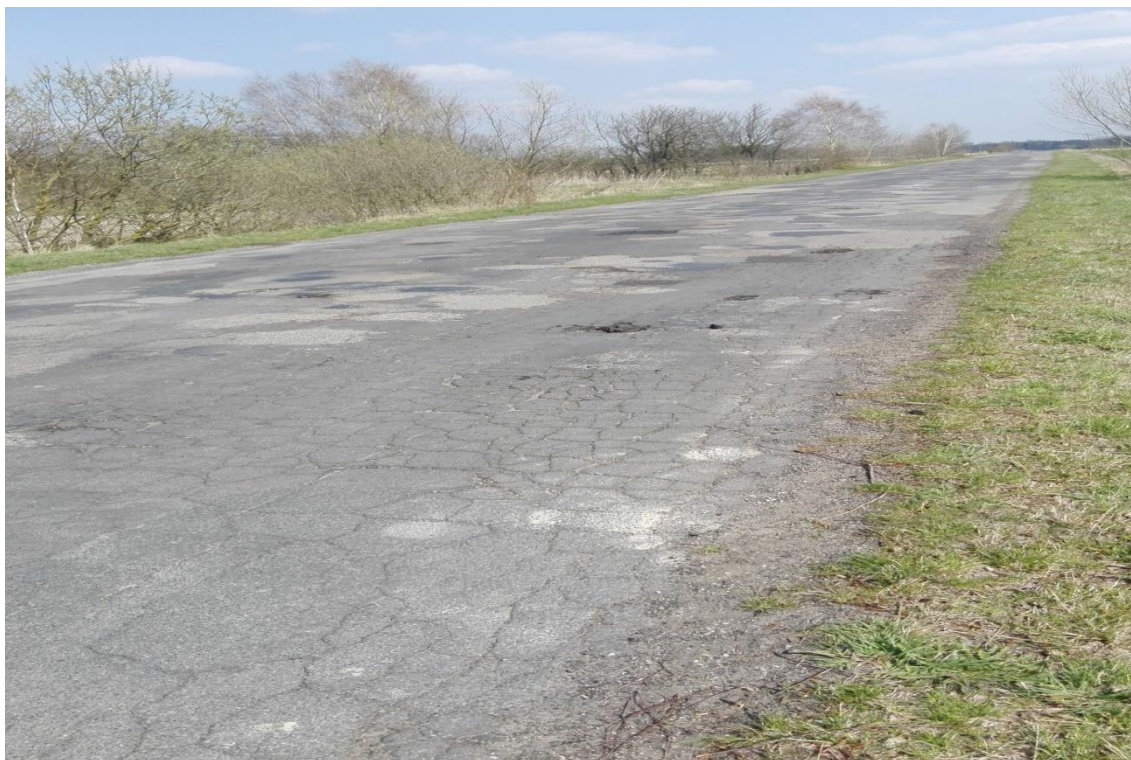
Fotografia 3. Droga Nr 1095L Nowy Holeszów – Holeszów
