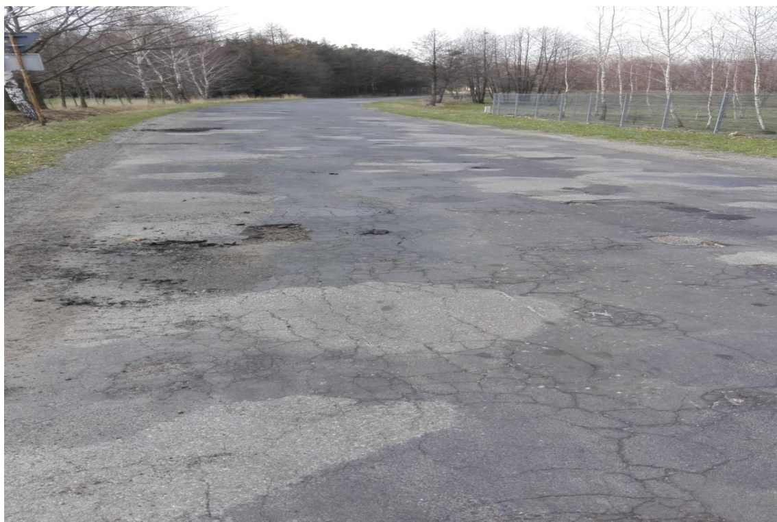
Fotografia 4. Droga Nr 1095L Nowy Holeszów - Holeszów
