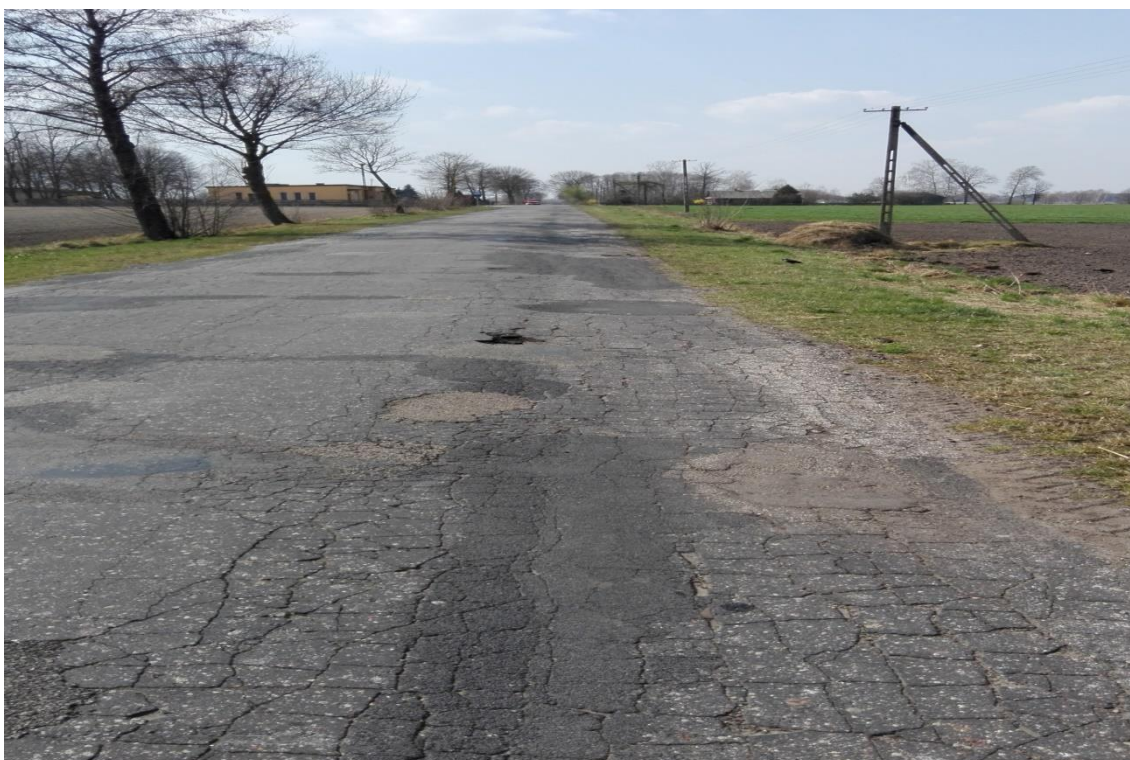
Fotografia 6. Droga Nr 1702L Zaświatycze - Lack
