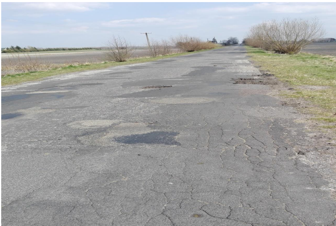
Fotografia 5. Droga Nr 1702L Zaświatycze – Lack
