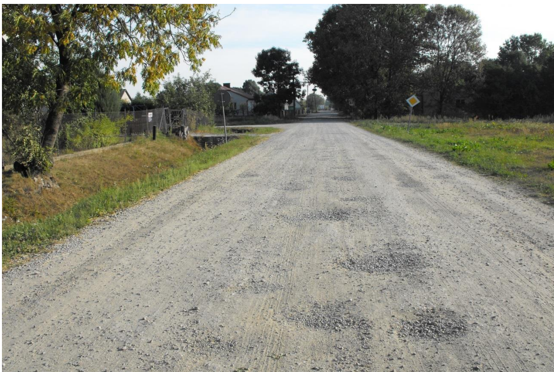
Fotografia 10. Droga Nr 1705L Korolówka – Kol. Różanka
