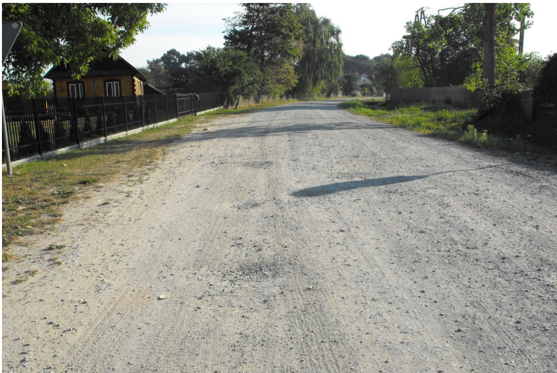
Fotografia 9. Droga Nr 1705L Korolówka – Kol. Różanka
